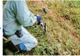
**⑦ アンカーによる押さえロープの固定**
